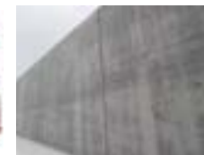
コンクリート壁の除染に
